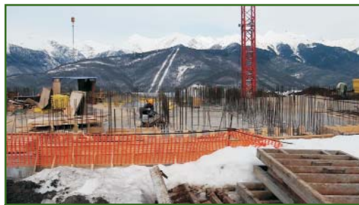
Фундамент будущей гостиницы на «Объекте 960 метров»
